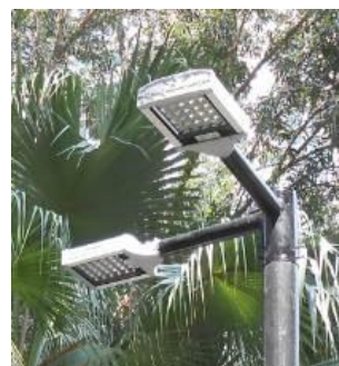
建議更換公園燈燈泡為節能燈泡及於燈柱頂部安裝反射板
